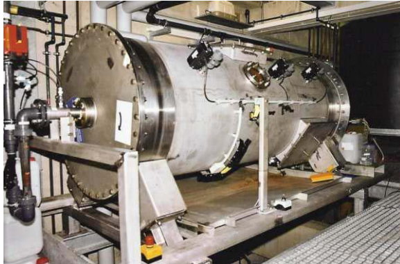
Technische Anlage aus Duplexstahl mit 3m 3 /h Durchsatz seit 2003 am Delphinarium Duisburg mit 3.000 m 3 Volumen
