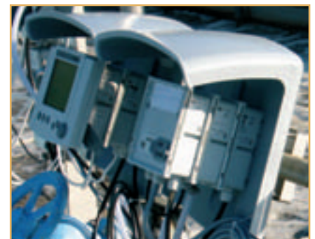
IQ SENSOR NET unter Schutzdach SSH/IQ
